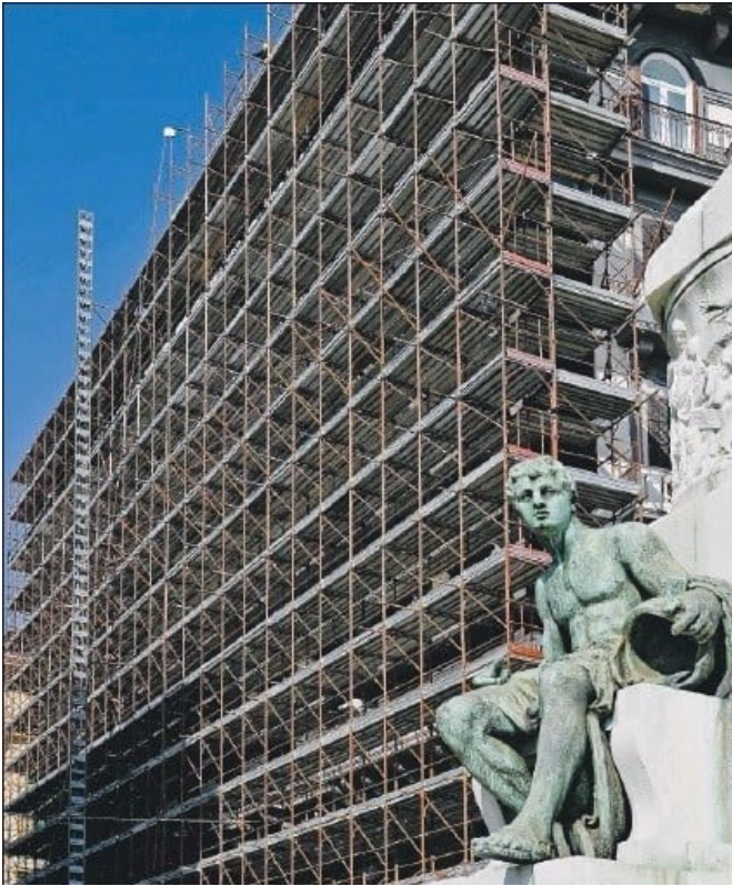
Un palazzo in fase di ristrutturazione della facciata nel quartiere Santa Lucia a Napoli (Ciro Fusco/ansa)
