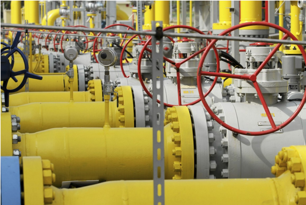
Condutture di Gazprom
