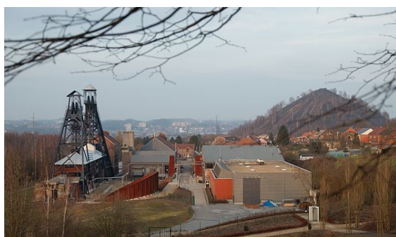
Panoramica di alcuni impianti della miniera
